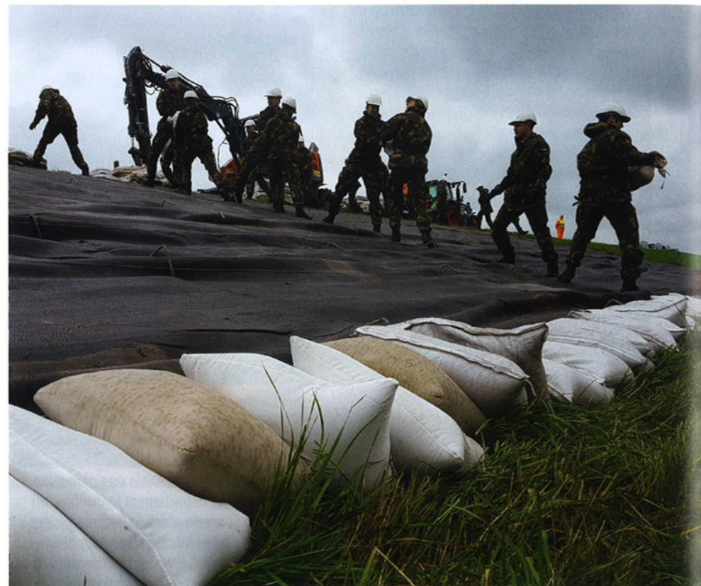
Oefening plaatsing bekramming waterschap Drents Overijsselse Delta en Nationale Reserve (NATRES) 16-09-2017.
