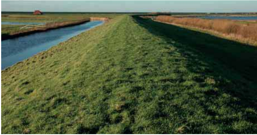
Een compartimenteringsdijk achter de Hondsbosse Zeewering in Noord-Holland.
